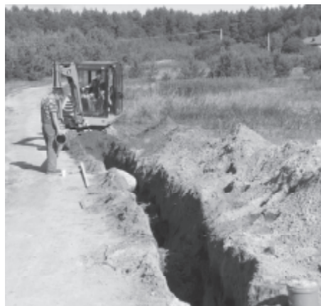
Prace przy budowie kanalizacji
