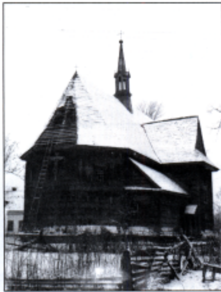
Prace konserwatorskie . Lata 60. XX w. Fot. w posiadaniu A. Trout
