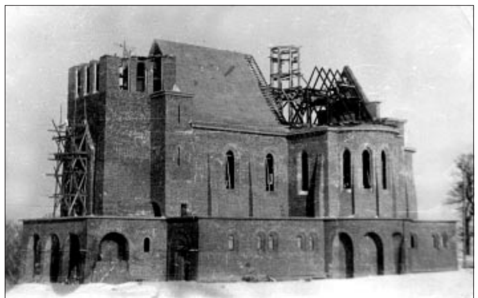
Kościół w trakcie budowy. Początek 1959 r.
