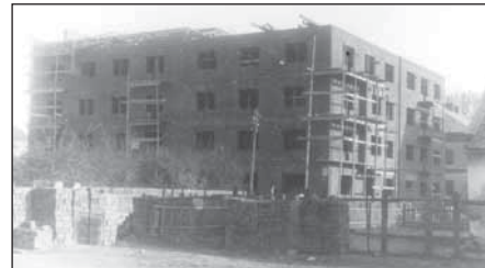
Kamienica Wangów przy ulicy Jagiellońskiej w Rzeszowie. Budowę dokończyli Niemcy na początku okupacji. Wprowadziło się tam Gestapo. Po wojnie budynek zajęła wojewódzka „bezpieka”. Obecnie mieści się w nim Komenda Miejska Policji.
