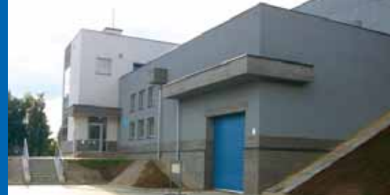
Nowy zbiornik wyrównawczy wody na osiedlu Krakowska Południe
