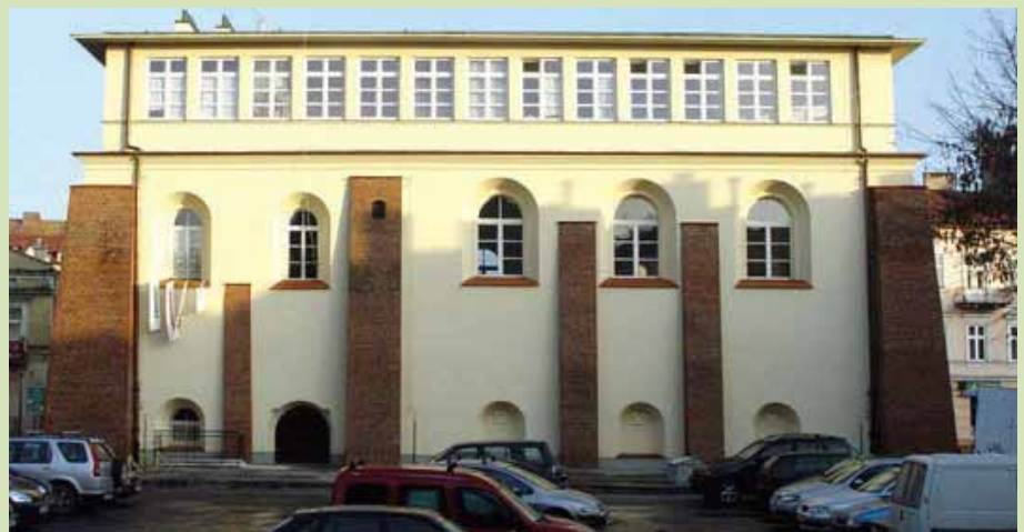
W grudniu ub. roku zakończono remont dachu i elewacji oraz wymianę okien na ostatniej kondygnacji budynku Biura Wystaw Artystycznych w Rzeszowie przy ulicy Sobieskiego. – Sprzyjała nam aura, dzięki temu remont trwał tylko trzy miesiące – poinformował art. malarz Ryszard Dudek, dyrektor BWA. – Teraz w nowej szacie budynek dawnej rzeszowskiej Synagogi Nowomiejskiej, siedziby największej na Podkarpaciu galerii sztuki współczesnej, jest ozdobą centrum naszego miasta.
