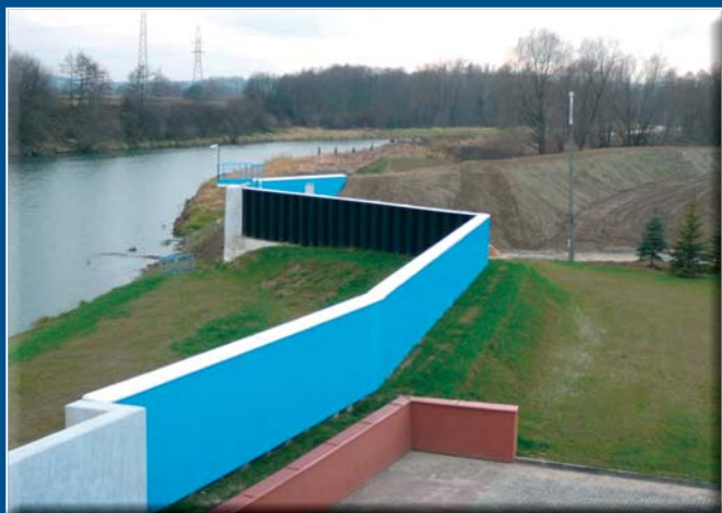
Nowe wały przeciwpowodziowe przy Zakładzie Uzdatniania Wody
