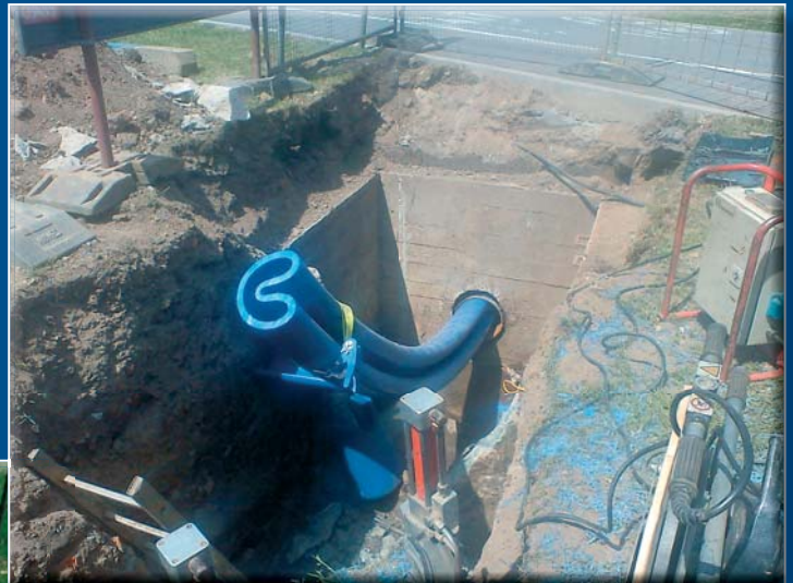
Przebudowa magistrali wodociągowej \varnothing 400 przy ul. Rejtana metodą bezwykopową
