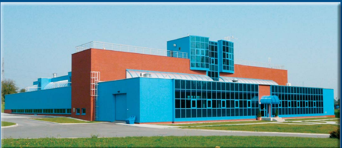
Budynek nowego bloku technologicznego na terenie Zakładu Uzdatniania Wody
