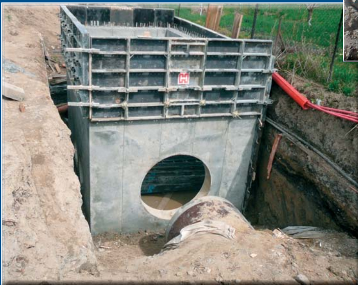
Budowa kanalizacji sanitarnej \varnothing 1200 w ul. Rejtana – Lwowska
