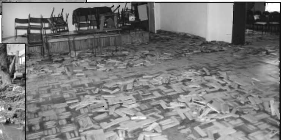
Zniszczenia wewnątrz Domu Strażaka w Rudzie.
