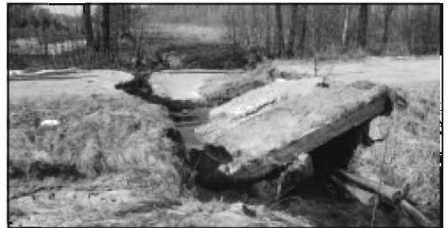
Rozmyty przepust w Rudzie – Zagacie.
