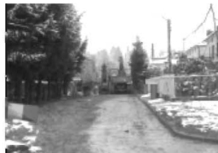
Budowa kanalizacji deszczowej na ul. Lipowej
