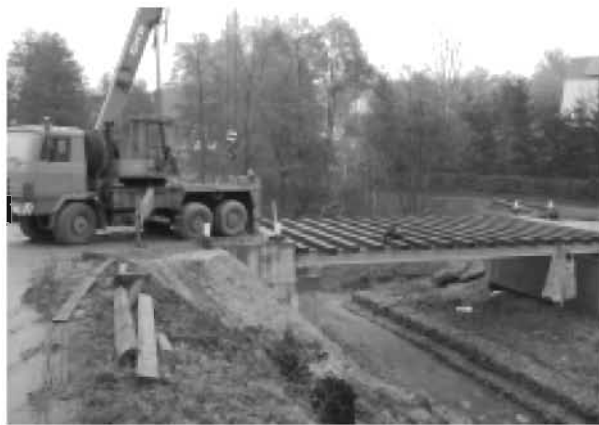
Budowa mostu w Zagorzycach
