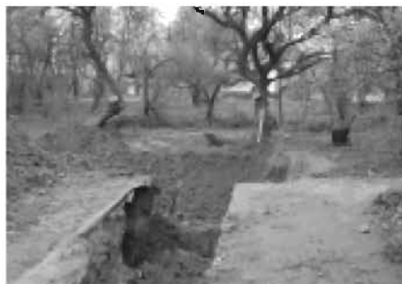
Budowa kanalizacji w Górze Ropczyckiej
