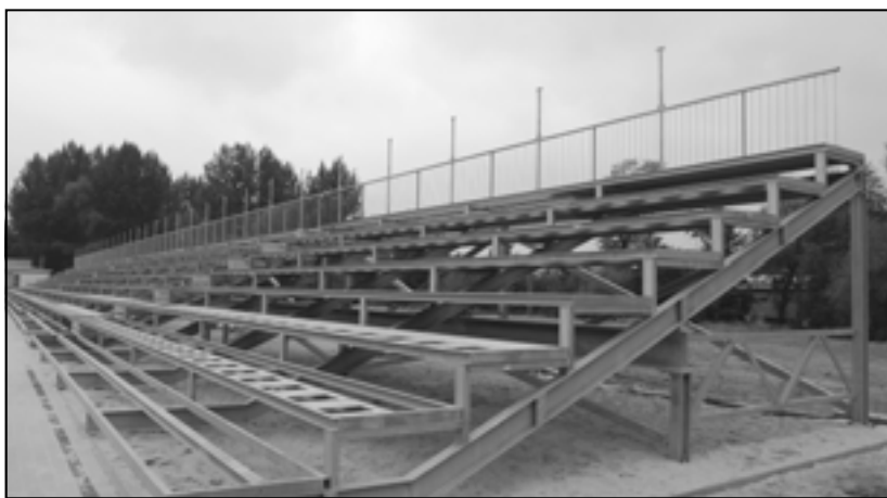
Konstrukcja trybun na stadionie Lechii w Śędziszowie Młp.
