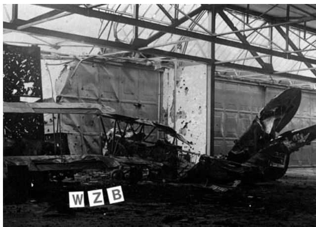
Zniszczony w czasie bombardowania hangar i samolot
