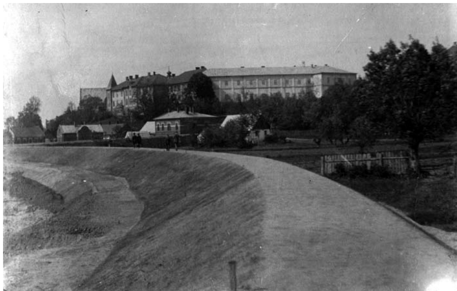
Świeżo wybudowane wały na rzece Lubatówce z widocznym budynkiem dawnego kolegium jezuickiego. Obecnie budynek dydaktyczny PWSZ.
