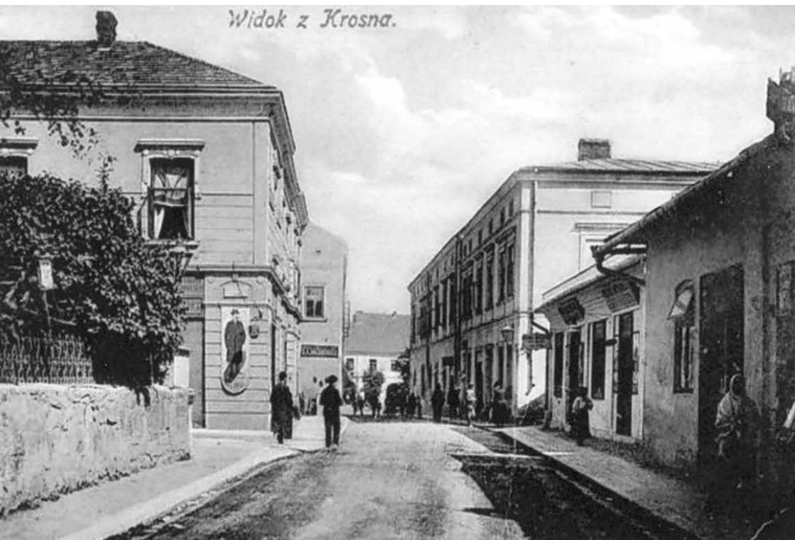
Widokówka sprzed I wojny światowej. Po prawej stronie wjazd z ul. Sienkiewicza w ul. Spółdzielczą, narożny parterowy budynek to obiekt naszych rozważań (ze zbiorów autora)
