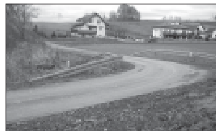
Odnowa nawierzchni ul. Spółdzielczej w Błazowej.
