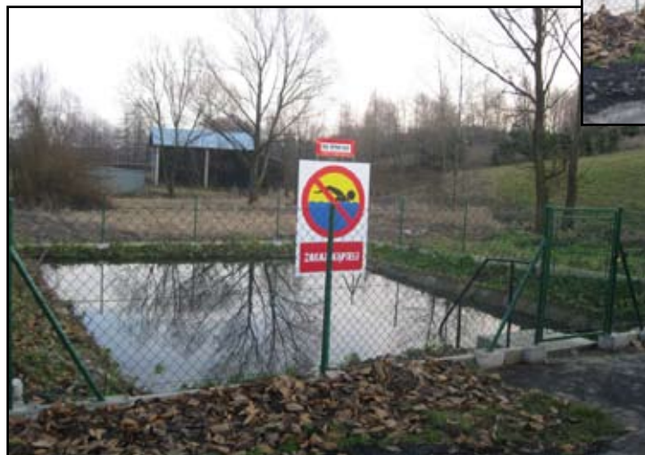
... oraz wyremontowany zbiornik przeciwpożarowy
