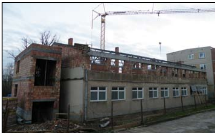
Rozbudowa Bloku Operacyjnego (fot. 1)
