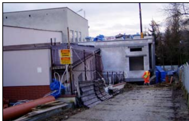
W dobudowanej części swe miejsce znajdą pracownia brachyterapii i rezonansu magnetycznego
