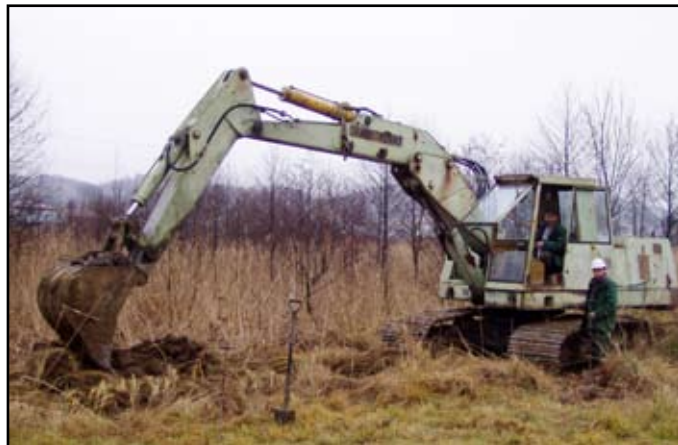
Rozpoczęcie prac przy budowie kanalizacji sanitarnej w Bliznem
