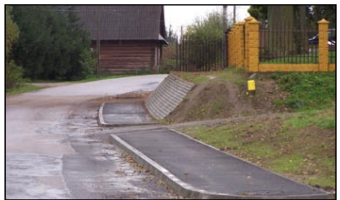
Nowo wybudowany chodnik w Bliznem
