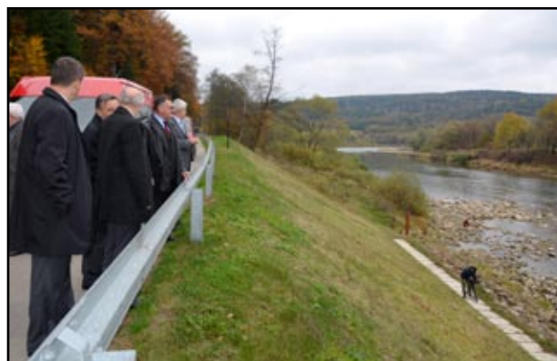
Lustracja zabezpieczonych osuwisk
