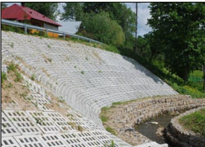
Zabezpieczone osuwiska w Witrylowie i w Przysietnicy
