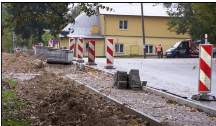
Zatoka autobusowa w Jasienicy Rosielnej
