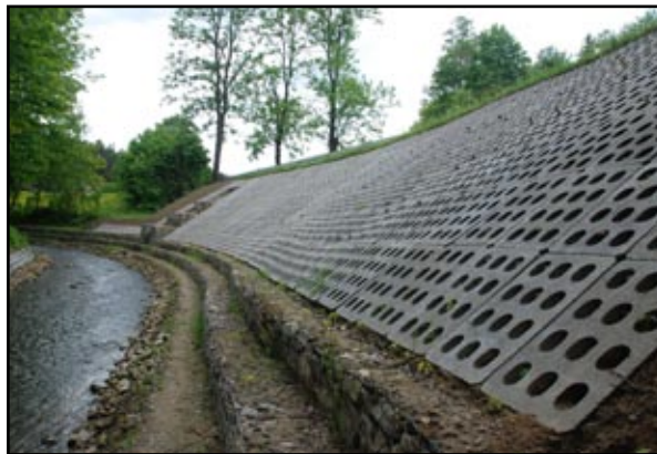
Zabezpieczone osuwisko w Warze w ciągu drogi Brzozów - Wara
