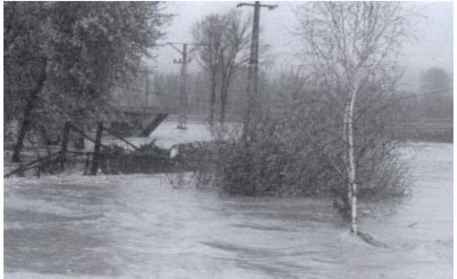
21 kwietnia 1998 r. Kładka i nowo budowany most w Kielnarowej podczas powodzi
