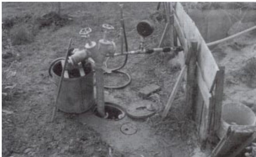
Próba szczelności wodociągu Biała - Mokra Strona wypadła pozytywnie
