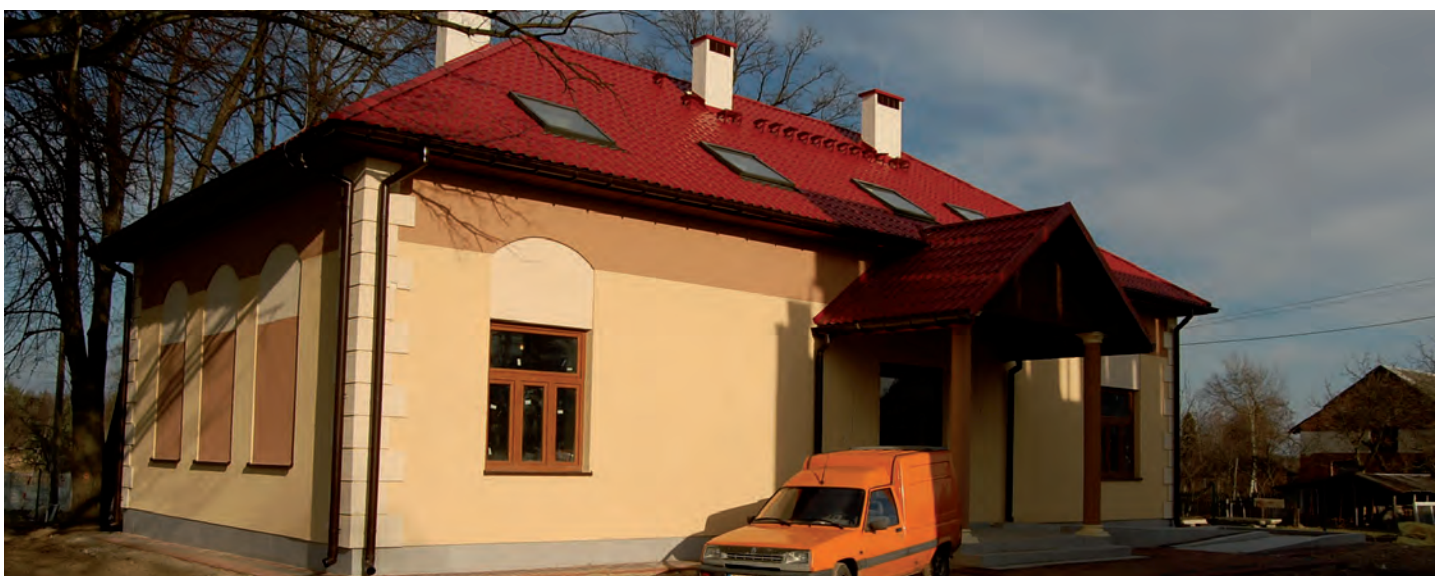
Na potrzeby ORW prowadzonego przez Stowarzyszenie Rodziców Dzieci Niepełnosprawnych w Grodzisku Dolnym modernizowany jest budynek starej szkoły w Laszczynach. Inwestycję prowadzi Stowarzyszenie. Wartość inwestycji 1 006 055 zł.
