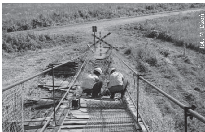
Prace rozbórkowe kładki
