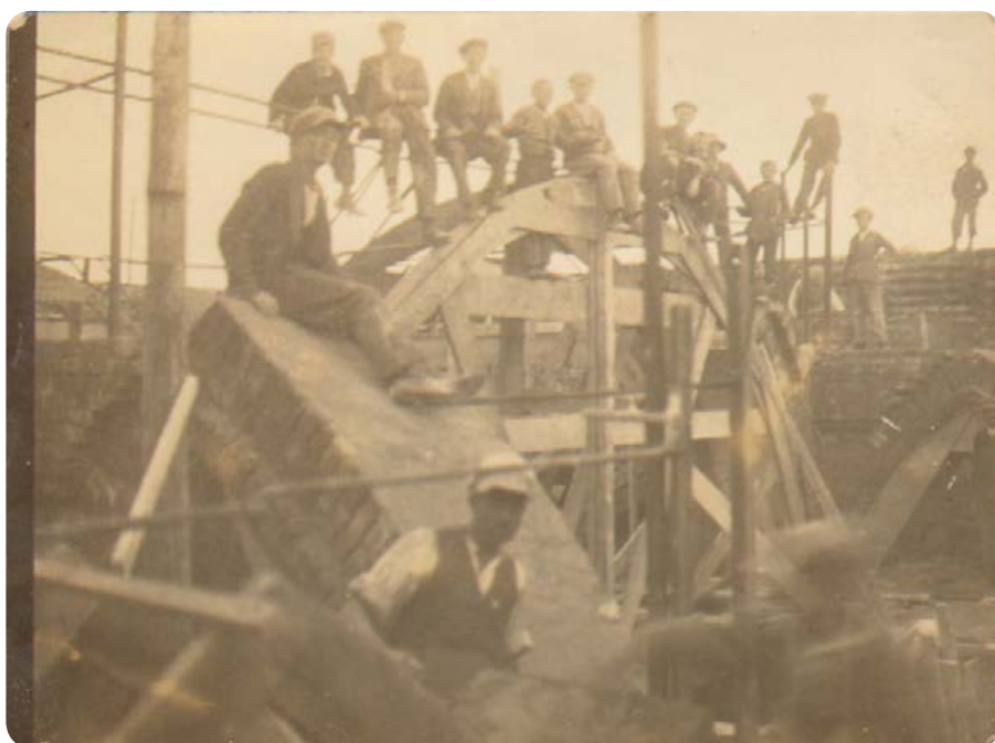
Budowa kościoła „Na Górze” w Miejscu Piastowym, czwarty od lewej Władysław Gradowicz, tato Stanisławy Wegrzyn
