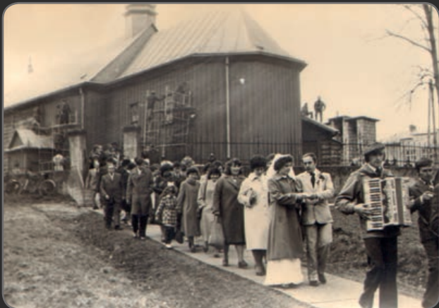
Wesele Czesławy i Ryszarda Gierków, w tle prace przy podnoszeniu kościoła w Targowiskach, 1982 r. Fot. z arch. Marty Lorenc
