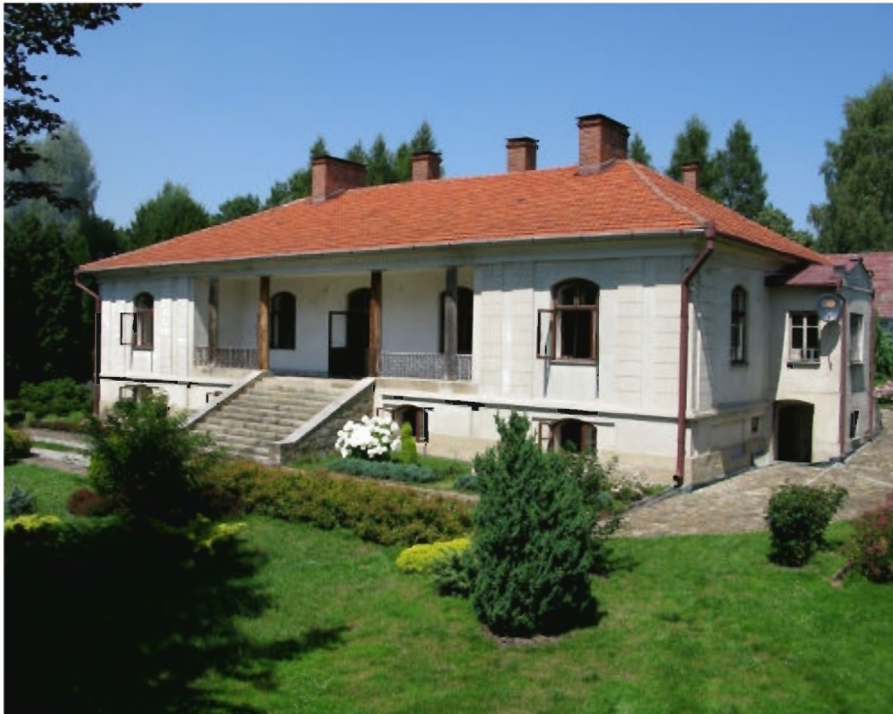
Widok ogólny zabytkowego dworu obronnego w Kielnarowej. Fot. Andrzej Domino
