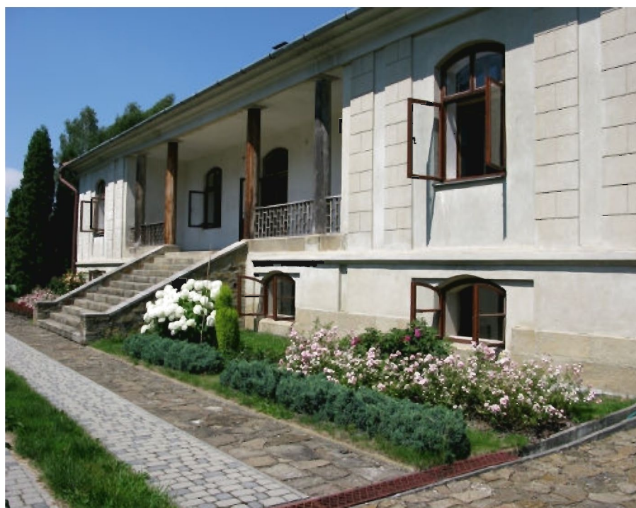
Dwór w Kielnarowej. Na zdjęciu schody oraz zachowane ciekawe elementy jego architektury zewnętrznej. Fot. Andrzej Domino
