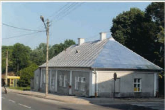
Przedszkole w Tyczynie widok przed remontem
