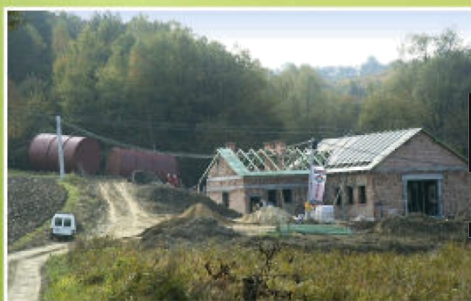
Stacja w budowie
