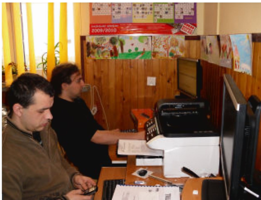
Instalacja nowego sprzętu w Filii w Hermanowej
