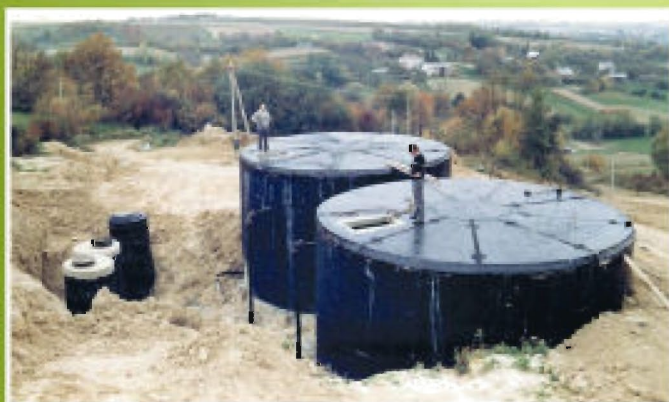
Zbiorniki wody czystej w czasie budowy i po obsypaniu ziemią. Prace zostały zakończone w 1993 r.
