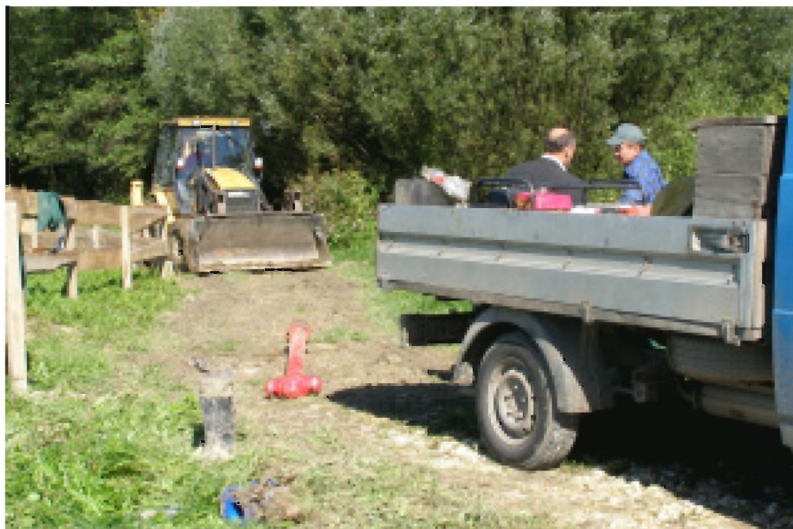
Budowa wodociągu Kielnarowa Zawodzie II
