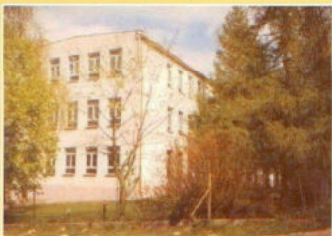
Rok 1998. Szkoła z dobudowanym II piętrem
