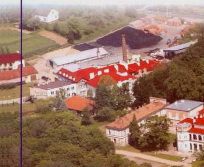
Pałac Wodzickich - elewacja południowa
