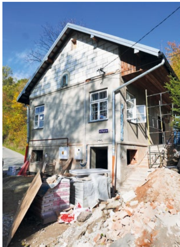
Dom dla repatriantów jest w trakcie remontu
