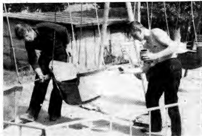
Na zdjęciu: Zb. Prus i R. Hodorowski (szkoła budowlana) malują huśtawki. Będą jak nowe. Fot. J. WOJTCWICZ
