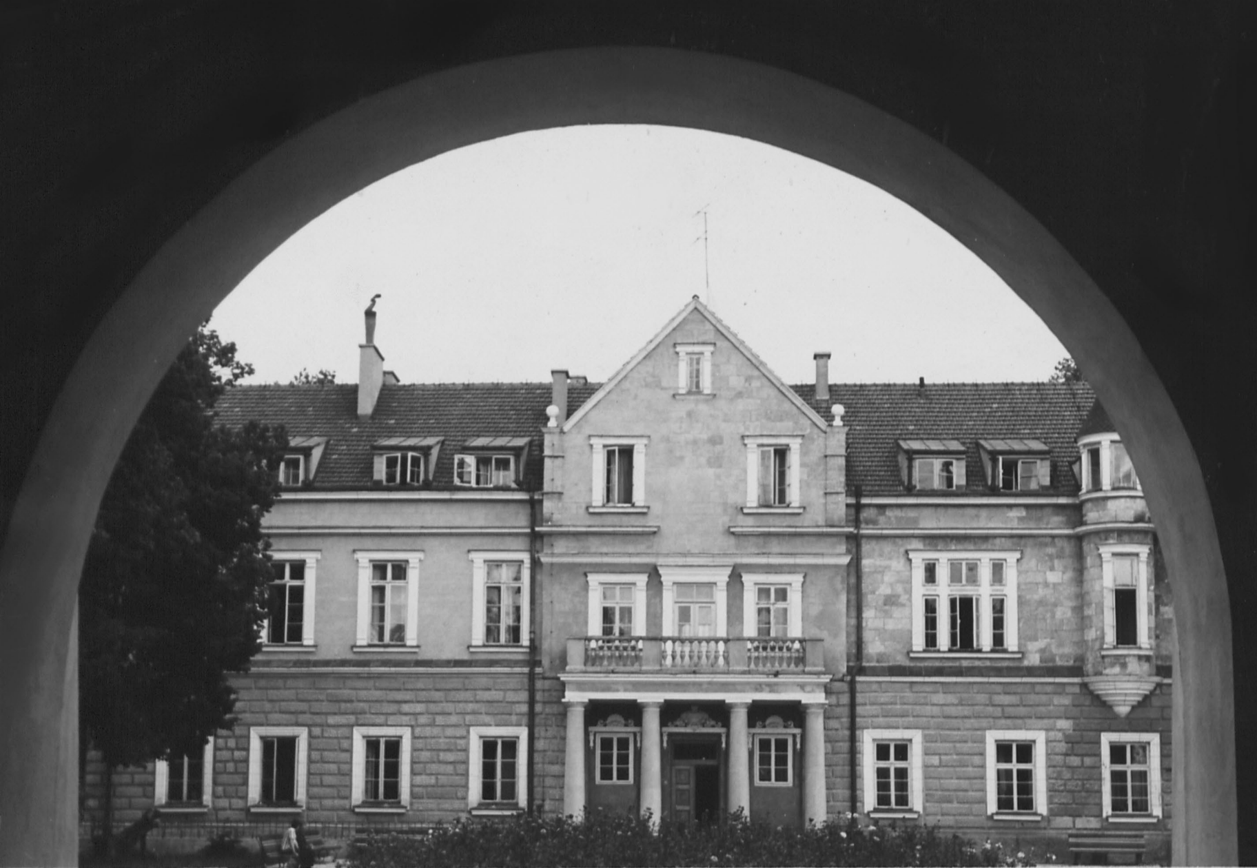
Horyniec Zdrój. W zabytkowym, odrestaurowanym pałacu Ponińskich (na zdj.) mieści się obecnie sanatorium Związku Zawodowego Metalowców. CAF — fot. A. Łokaj
