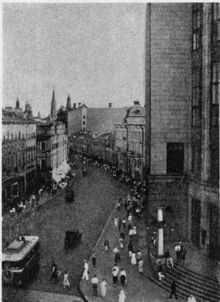
11. Ул. Горького до реконструкции
