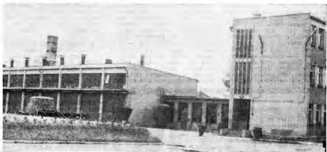
Pięknie prezentują się obiekty OTL w Przemysłu. Za dwa lata przybędzie jeszcze jeden budynek (kosztów około 5,5 mln zł), w którym znajdą pomieszczenie: hala produkcyjna, świetlica, hotel robotniczy i stołówka.
