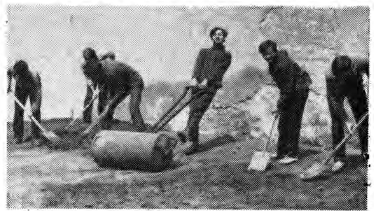
Chłopcy z osiedla przy ul. Dzierżyńskiego równają plac pod boisko siatkówki.
