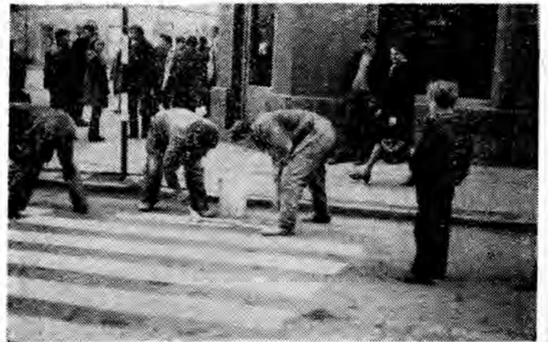
Malowanie pasów na jezdniach. Jeśli w tym miejscu będziemy przechodzić ulicę, wypadek nam nie grozi. Tot. TZ
