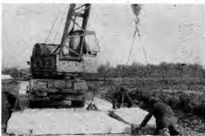
Zespół pracowników układa drogę z płyt betonowych.
