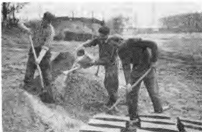
Michał Zakrzewski, Eugeniusz Grzeszczak i Władysław Zajac z Okręgowego Zarządu Wodnego, pracują przy budowie plaży, na przystani wodnej.
