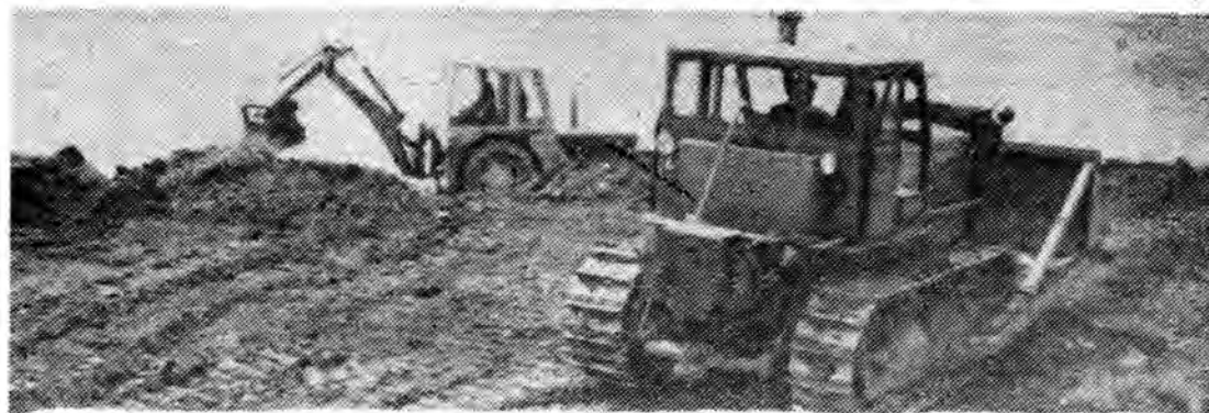
Operatorzy Józef Pięta pracujący na spychaczu i Ludwik Jach — na koparce zastępują z powodzeniem kilkuset robotników „uzbrojonych” w łopaty. W ciągu kilku dni wyrównali kilkusetmetrowy odcinek bulwaru nad Sanem. Jeszcze w tym sezonie będzie tu piękna plaża.
