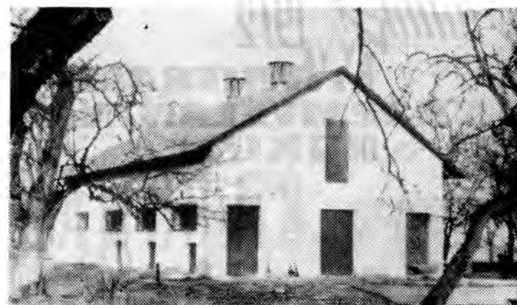
W zagrodzie Bojddów z Aksmanic najokazalsza jest chlewnia; powstała w rekordowym tempie: wykopy pod fundamenty robiono w maju, a już w październiku — w pachnącym wapnem budynek — pochrząkiwały prosięta.
