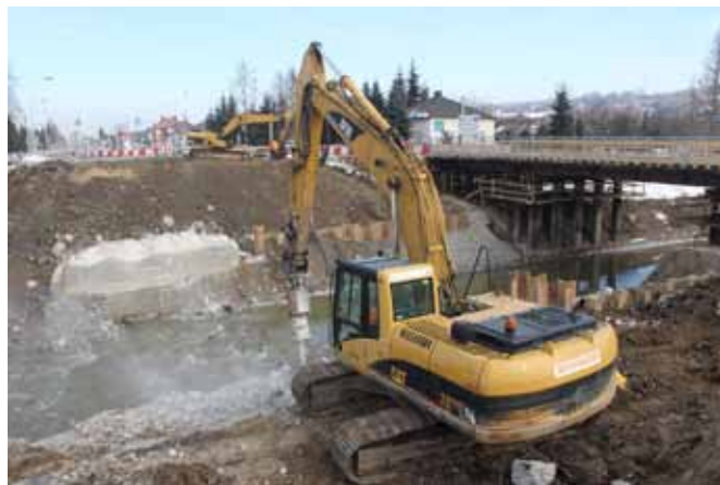
Prace na moście w Tyczynie. Stan prac z marca br.
