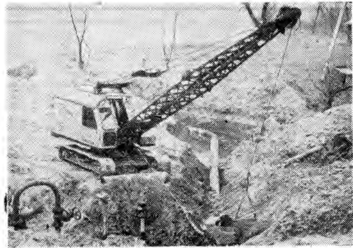
Woda i błoto w przekonaniu pracowników „Naftobudowy” dobrze konserwują koparkę.
