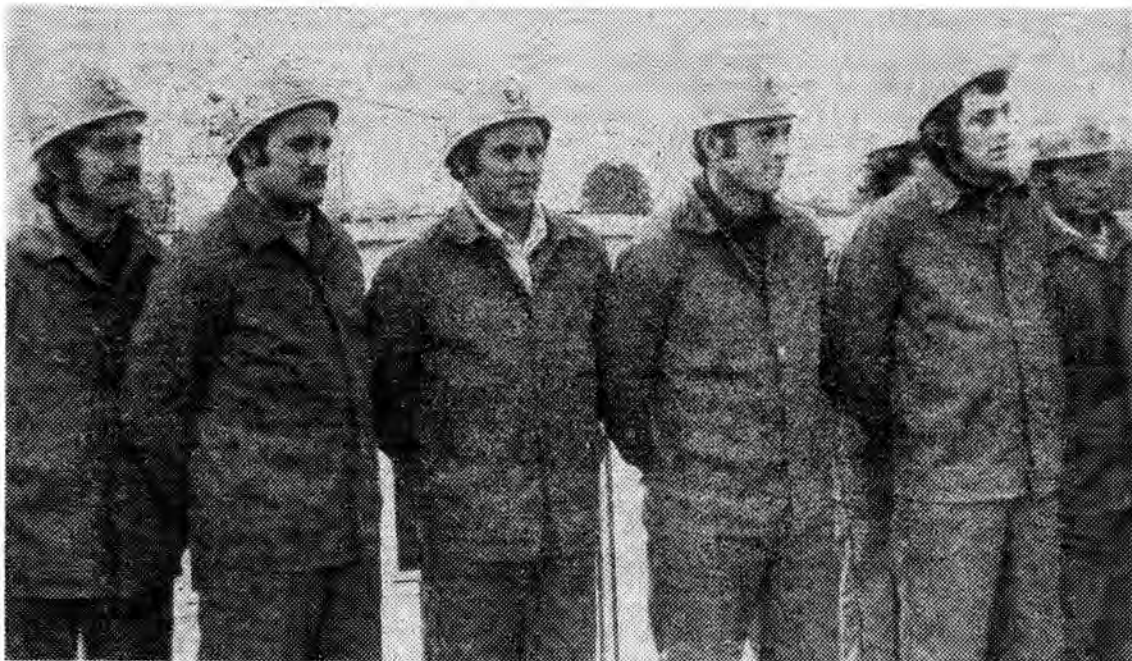
Grupa górników — budowniczych doświadczalnej kopalni siarki w Smolince — Baszni.
