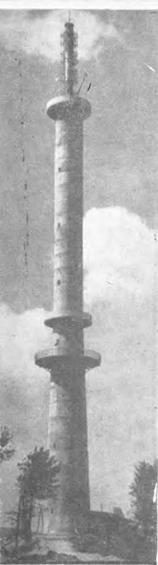
Wieża przekaźnikowej stacji telewizyjnej na Suchej Górze koło Krosna
