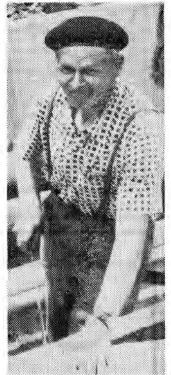
Antoni Czyż — cieśla, bardzo dobry, a przy tym pracowity fachowiec (na zdjęciu przygotowuje tzw. poduszki pod kanał centralnego ogrzewania).
