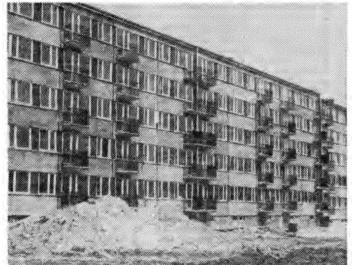
Załoga JPB oddała przed terminem 6 klatek (łącznie 75 mieszkań) nowo budowanego osiedla przy ul. Grunwaldzkiej. Pozostałe przekazywane będą sukcesywnie wraz z postępem robót wykończeniowych. Pracuje tu wielu dobrych fachowców, a wśród nich prezentowani na zdjęciach.
