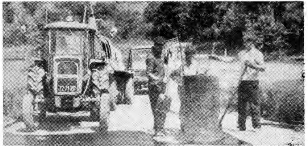
Ośrodek stale się rozbudowuje. Pracownicy Rejonu Dróg Publicznych wylewają asfalt na dojazdowe drogi i dróżki. Fot. T. ZIEMBOLEWSKA
