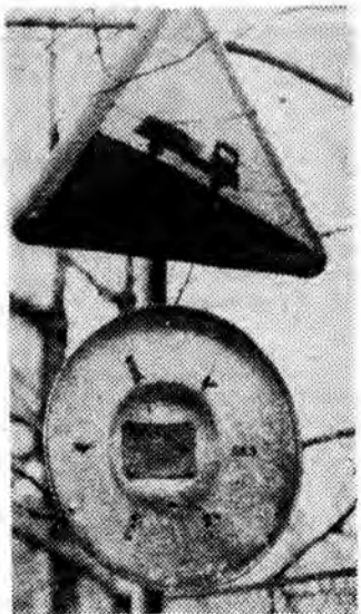
A to już przykład wandalizmu (zniszczony znak drogowy przy ul. Wągartal). Fot. TZ
