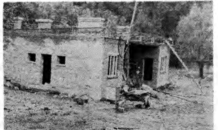
Trwa budowa mini-dworca PKS.
