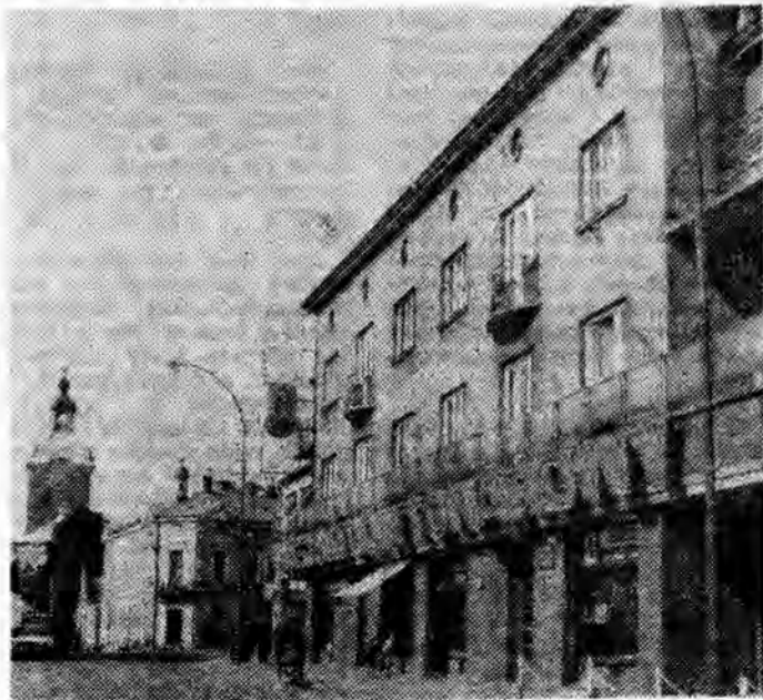
W Przeworsku na szeroką skalę prowadzone są prace porządkowo-estetyczne.
