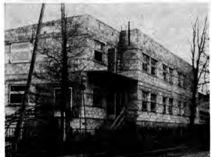
Budynek socjalny jeszcze w stanie surowym, ale już wkrótce zacznie spełniać swoje funkcje. Fot. T. ZIEMBOLEWSKA
