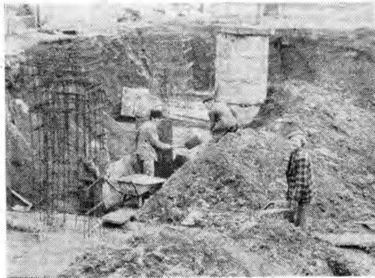
Budowniczo nową restaurację jeszcze przy lanu fundamentów zapewniają, że w czerwcu przyszłego roku zakład gastronomiczny będzie przygotowany na przyjęcie pierwszych konsumentów.
