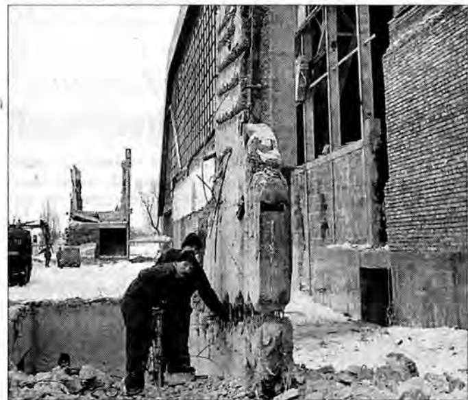
20 mln zł przyspieszy remont hali na Podpromiu.
