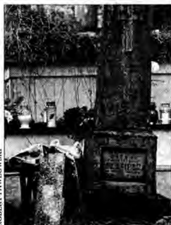
Wielu zabytkowym grobowcom na Cmentarzu Głównym grozi zagłada.
