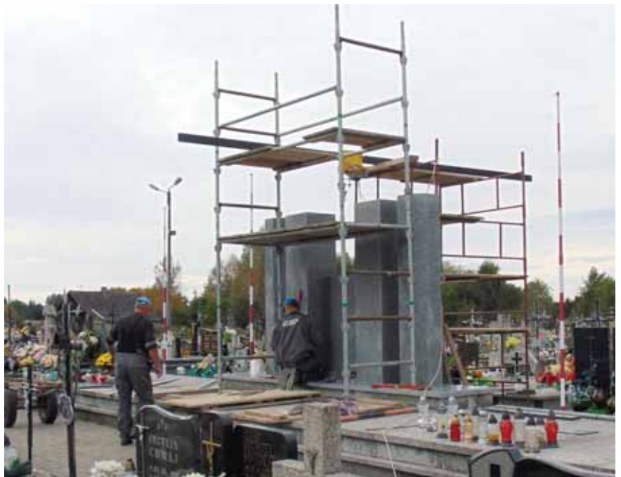
Prace remontowe przy zbiorowej mogile.
