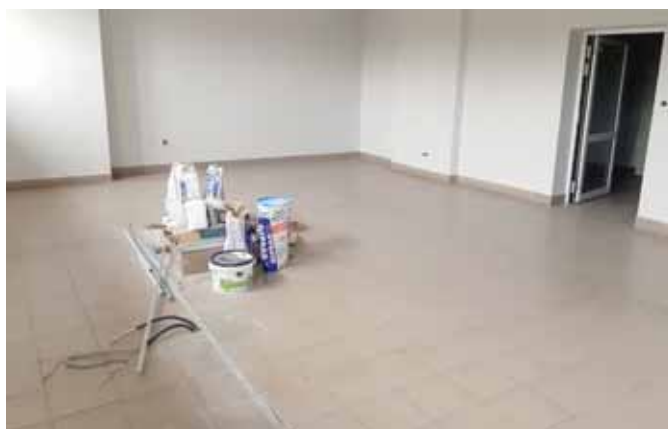
Rudna Wielka. Nowe pomieszczenie biblioteczne w trakcie wykonywanych prac
