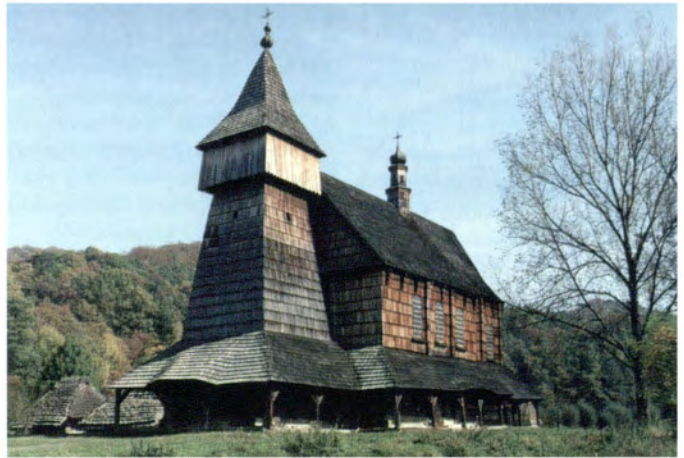
Kościół pw. Św. Michała z Bączala Dolnego, 1667, w skansenie w Sanoku
