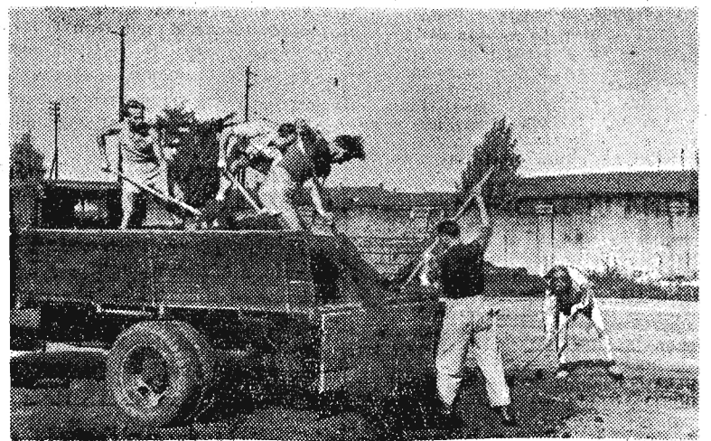
Kursiści zajęci przy plantowaniu terenu pod boisko szczypiórniaka które w porze zimowej ma służyć za boisko hokejowe.
