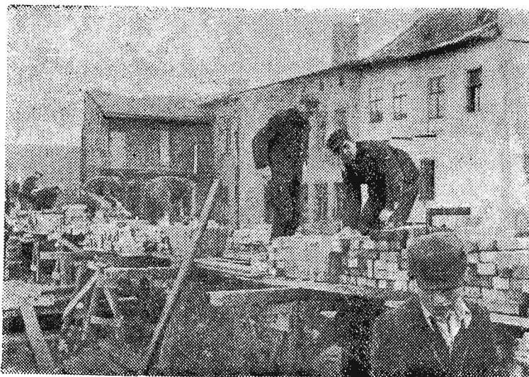
Na wielu budowach w Rzeszowie rozpoczął się wiosenny sezon budowlany. Hasło do tych prac dali członkowie Spółdzielni Budowlanej, stawiający własną siedzibę przy ul. Kopernika.
